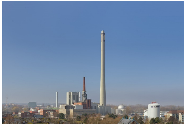
Abbildung 12: HKW-Mitte (Quelle: BS|ENERGY)
