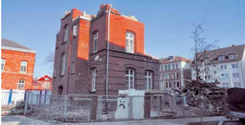
Abbruch Krankenhausverwaltung Foto W. Wiechers
